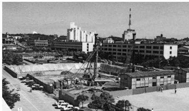
新築工事中の中央図書館（1980年）
