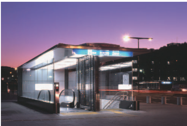
地下鉄名古屋大学駅 (撮影：車田保)
