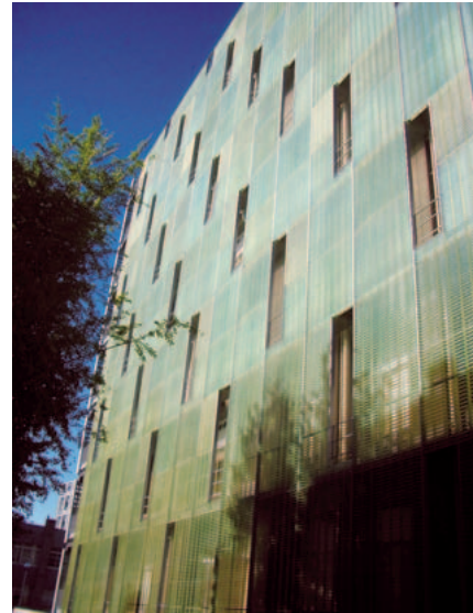
外壁南面 FRP 製グレーチング
