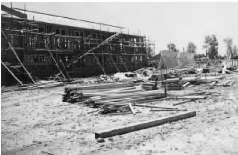
建築中の農学部新校舎
