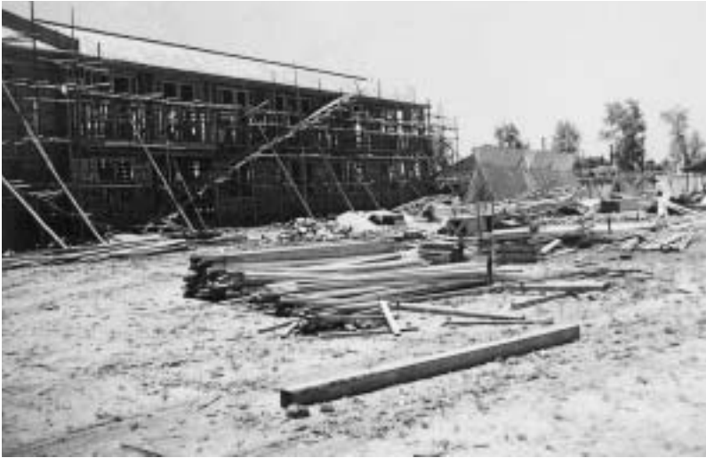
建築中の農学部新校舎
