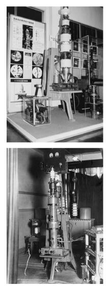
【図11】現在博物館にあるHU-2型電子顕微鏡(上)と 1942年当時のHU-2型電子顕微鏡(下)
